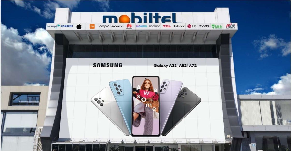
Mobitel Binası – Çobançeşme E5 Karayolu Üzeri / İstanbul
